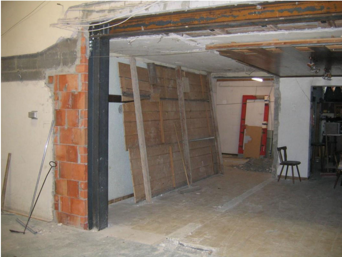
Bild 33: Die Sanierung und Umbau des alten Sportheims im Januar 2008
