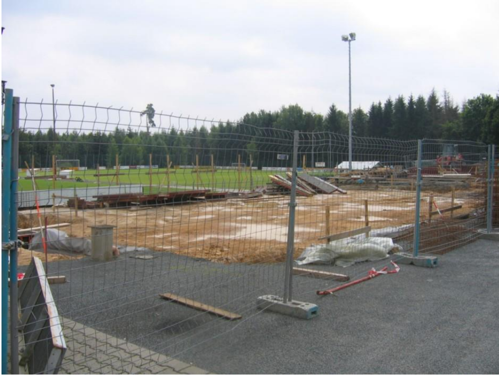
Foto 28: Baubeginn der Kultur und Sporthalle im Juli 2005
