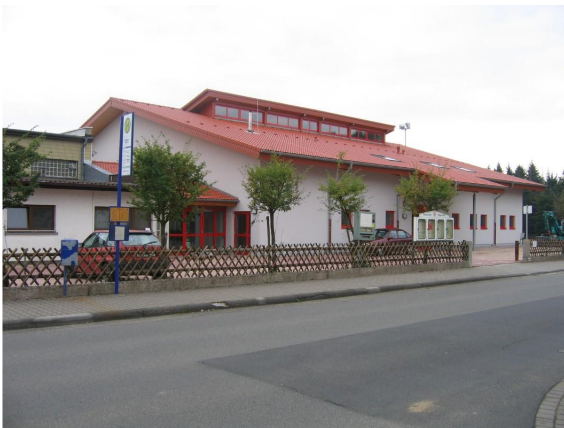
Bild 32: Die fertige Sporthalle im September des Jahres 2007
