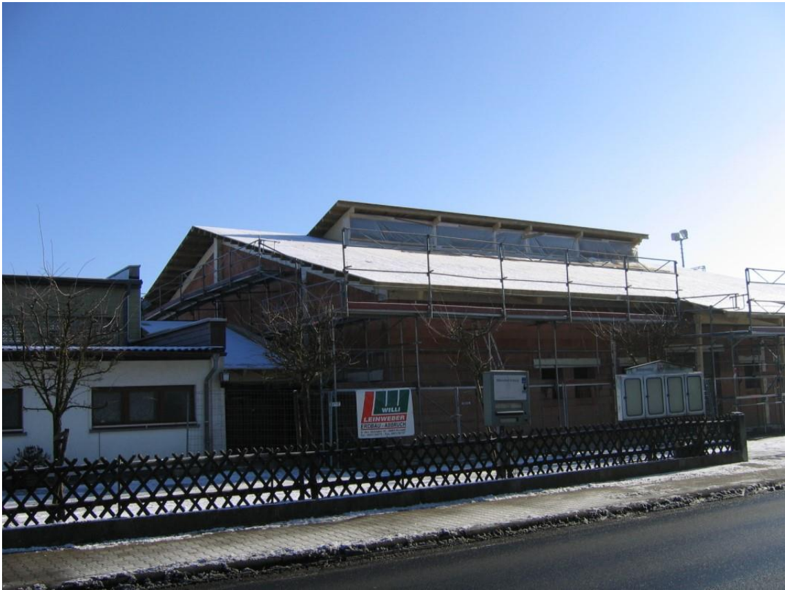
Bild 30: Dacharbeiten auf der neuen Halle im Januar 2006
