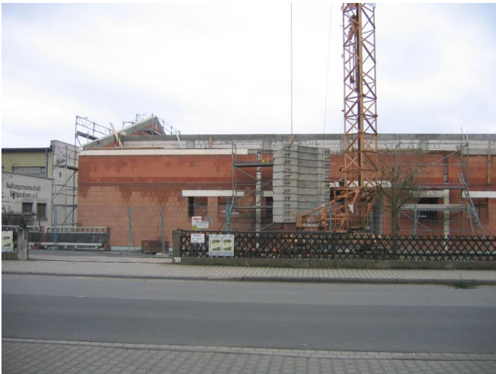
Foto 29: Rohbau der Halle im Oktober 2005
